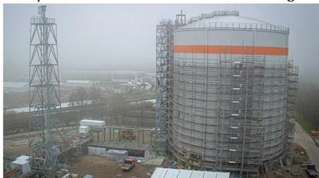
Zustand gelagert wird. Zur Druckabsicherung wurden auf dem Dach je Tankraum drei Über- und Unterdrucksicherungen installiert. Eine Wasserstandsprobe wurde bereits im vergangenen Sommer durchgeführt. „Ende April wird der Tank mit Stickstoff gespült, bevor mit der Einleitung von gasförmigem, warmen Ammoniak begonnen werden kann“, kündigt der Abteilungsleiter Projektierung/Projektmanagement Udo Riedel an. Die Inbetriebnahme mit kaltem, flüssigem Ammoniak ist für Juni 2025 geplant.
